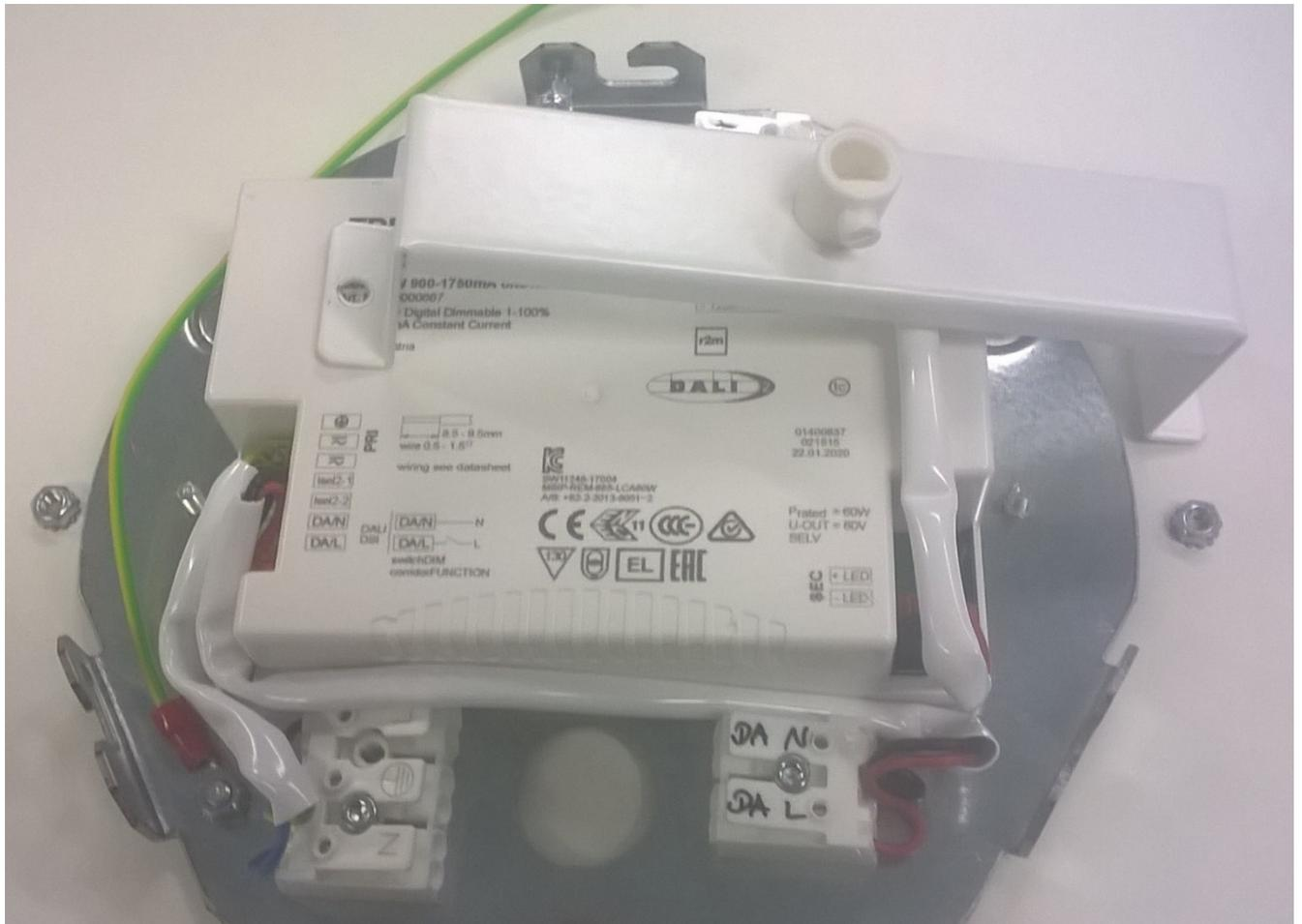
Die Pendelleitung in die Zugentlastung einschieben bis der Mantel der Leitung mit der Zugentlastung bündig ist. Abmantellänge = 120mm!!
