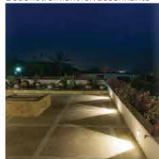
TERRASSE Bodenstreiflicht Terrassenkante
